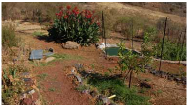
Sistema integrado de tratamiento y reciclaje de aguas grises y negras, incluye biodigestor anaeróbico, humedal artificial, estanque, "drenajes enramados" para reutilizar el agua en el riego de plantas medicinales y árboles frutales (Granja Familiar Tierramor, Junio 2008)
